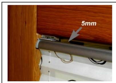
Precisiamo che l'uso delle piastre adesive come sistema di montaggio comporta uno spazio di luce di circa 5mm sia sul lato superiore che sul lato inferiore fra il profilo tenda plissè e il fermavetro infisso
